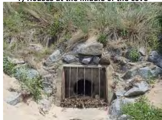
h) Stormwater outlet
