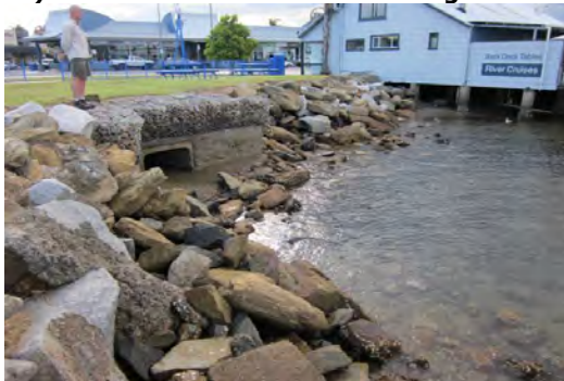
g) Stormwater outlet
