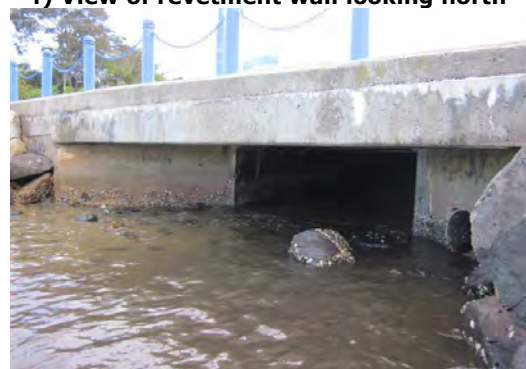
h) Stormwater outlet
