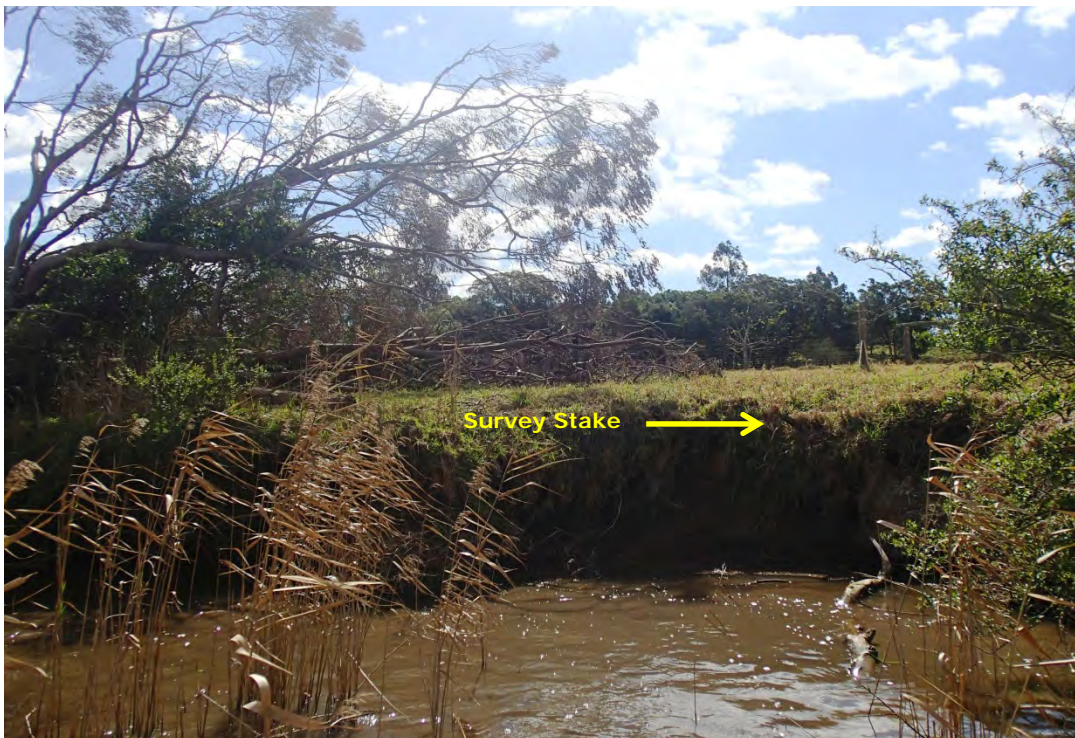
Figure R-3 : DLCS Monitoring Site 7 (August 2015)
