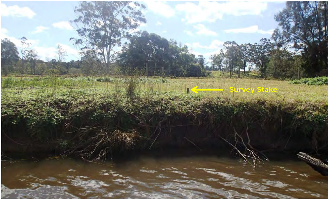
Figure R-2 : DLCS Monitoring Site 4 (August 2015)
